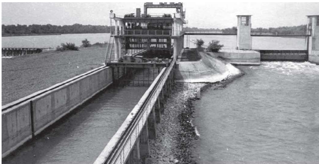
Рисунок 2. Рыбонакопительный лоток рыбопропускного шлюза Кочетовского гидроузла
