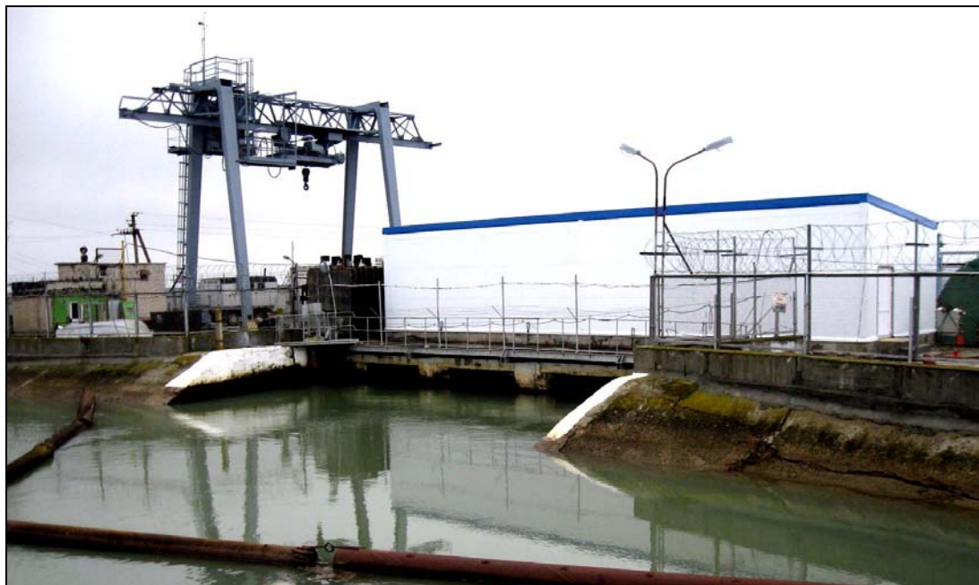
Рисунок 2. Барсучковский водозабор Невинномысской ГРЭС (общий вид)
